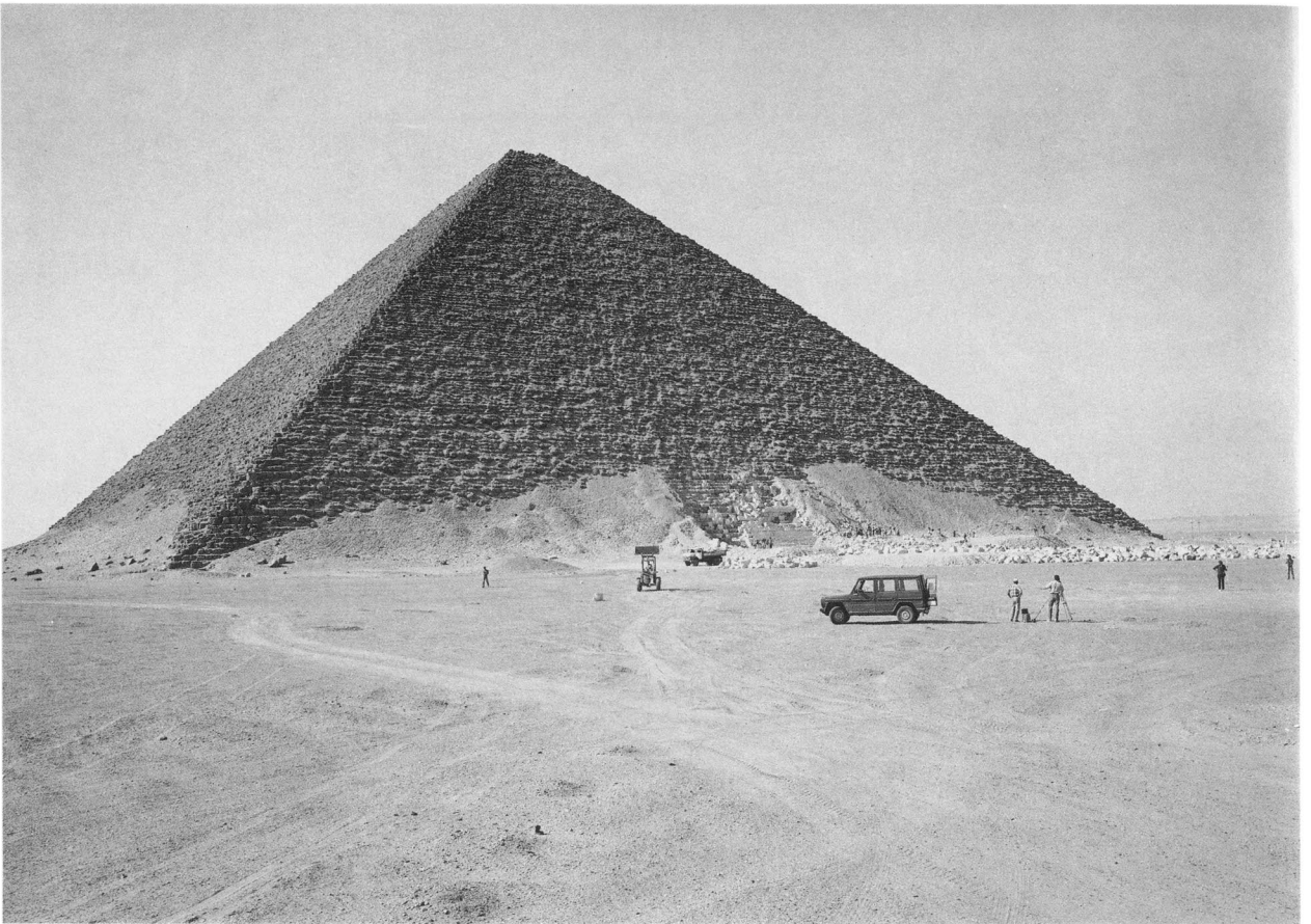
Taf. 31 Dahschur/Nord. Blick von Osten auf die Rote Pyramide und die Ausgrabungen des Deutschen Archäologischen Instituts Kairo an der Ostseite. Die Schuttmassen, die vom Abbau der Kalksteinverkleidung im Mittelalter herrühren, reichen an den Pyramidenflanken bis zu 17 Meter hoch und bedeckten die Fundamentreste des Totentempels.
